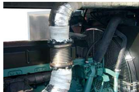
Compensatore gas di scarico Exhaust gas compensator Compensateur déchetement
