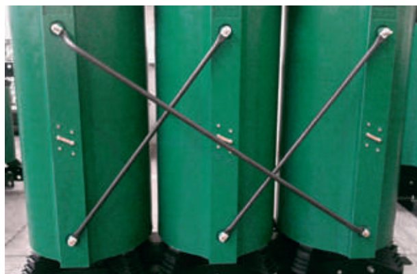
Пример выполнения выводов обмотки высокого напряжения
