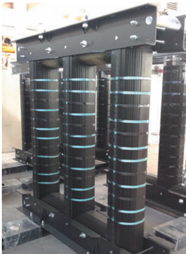
Пример магнитного сердечника
