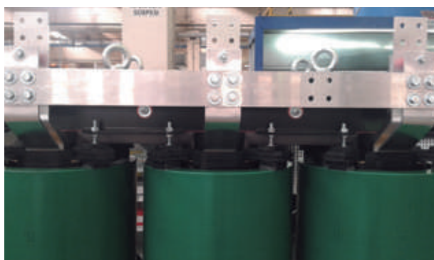
Пример выполнения выводов обмотки низкого напряжения
